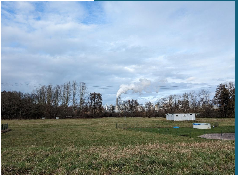
Usine EGGER à Rambervillers (Source : ATMO Grand Est)
