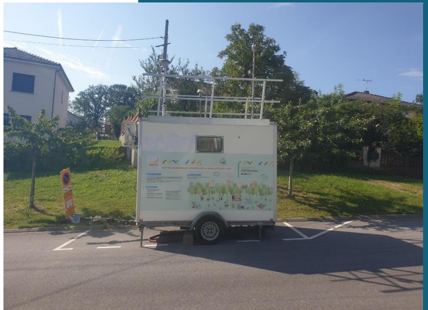
Unité mobile mise en place à Toul (Source : ATMO Grand Est)
