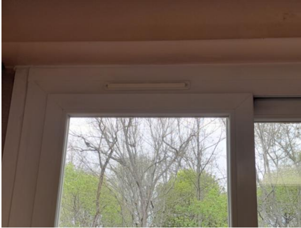
Figure 1 : Réglette d'entrée d'air sur fenêtre Source : Cerema
